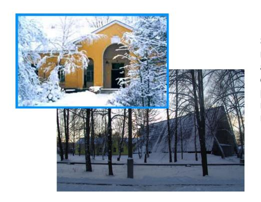
Здание и аппаратурный зал отдела космических лучей ИЗМИРАН. Крыша аппаратурного зала для уменьшения влияния снега выполнена в виде шатра. В зале расположены основные детекторы - нейтронный супермонитор 24nm64 и мюонный телескоп.
