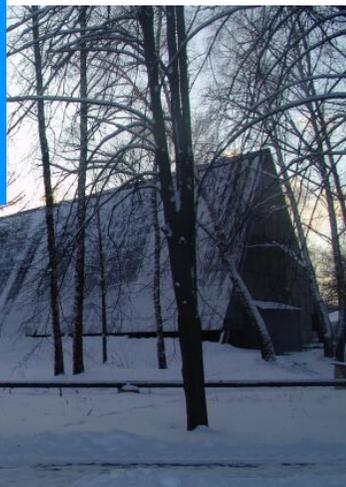
Здание и аппаратный зал отдела космических лучей ИЗМИРАН. Крыша аппаратного зала для уменьшения влияния снега выполнена в виде шатра. В зале расположены основные детекторы - нейтронный супермонитор 24nm64 и мюонный телескоп.
